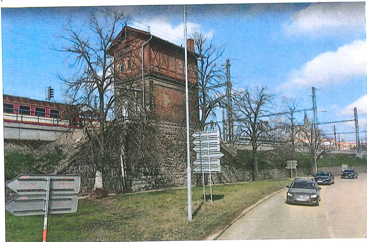
p.č.1380 k.ú. Staré Brno
