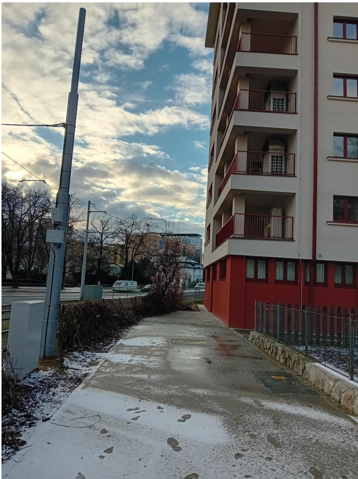
Pohled na část pozemku p.č. 798/2 v k.ú. Staré Brno, která je užívaná jako příjezdová komunikace
