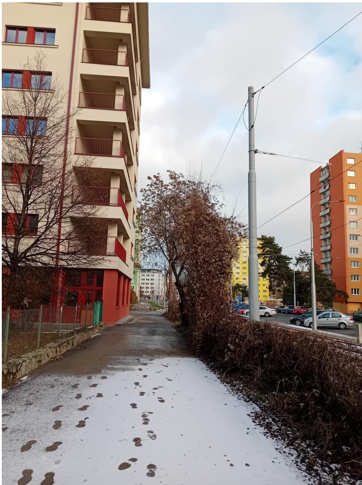
Pohled na užívanou část pozemku p.č. 798/2 v k.ú. Staré Brno, která je užívaná jako příjezdová komunikace
