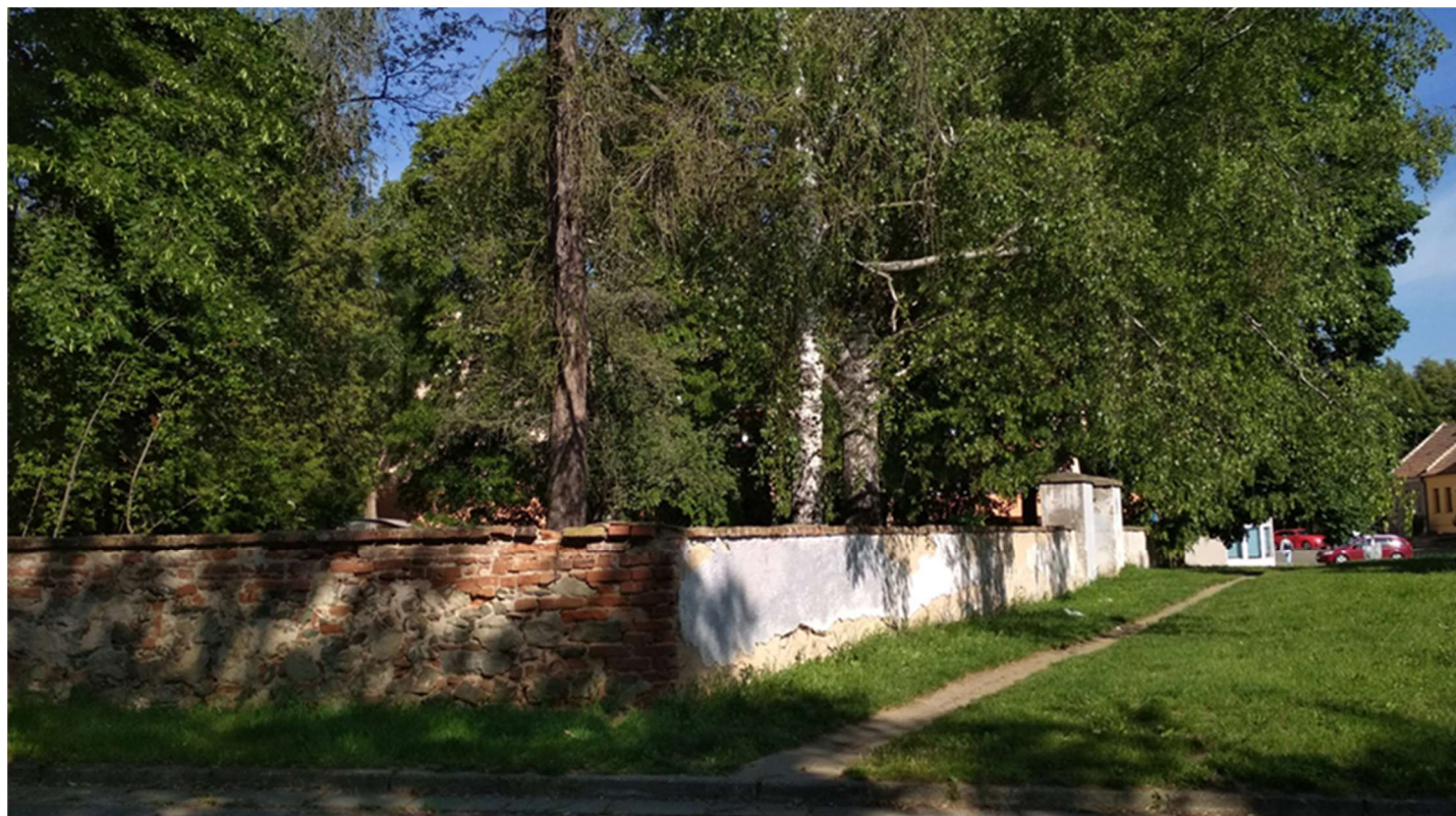
vstup do území ze severovýchodní strany, starší část zdiva (smíšené zdivo)
