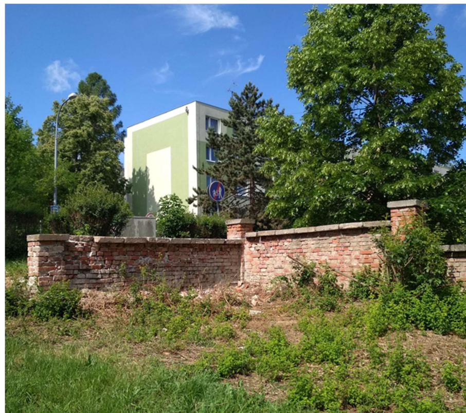
mladší část zdiva (cihlové zdivo)
