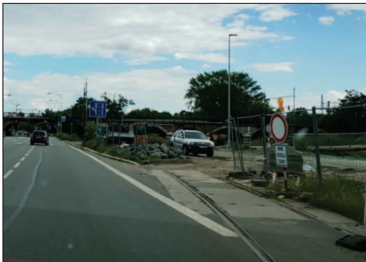
Nájezd do ulice Poříčí, křižovatka s ul. Heršpická
