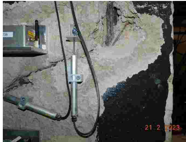
Foto z instalace 21.2.2023, detail snímače DH15
