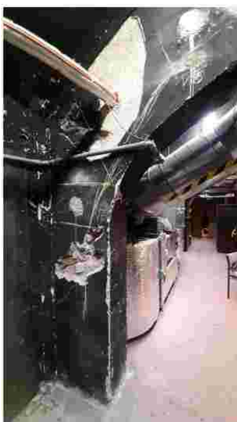
Obr.11 : Celkový pohled na místo sondy S5M spolu s vykreslením polohy trhlin a výztuže jasně ukazuje, že průběh trhliny souvisí se způsobem vyztužení, a velkou roli hraje poloha třmínků ve sloupu.
