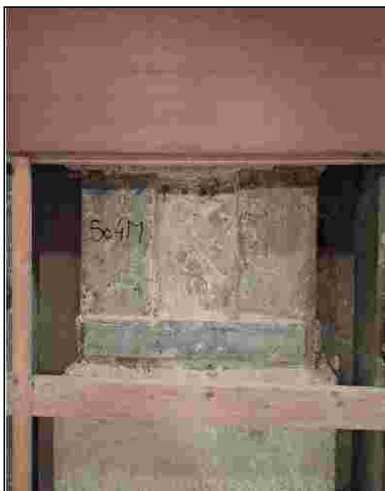
Obr. 2: Sloup Sc4M, kde je v zpřístupněné oblasti patrná ocelová bandáž v podobě úhelníků 200x200 mm tloušťky 30 mm a opásání ocelovými pláty šířky 100 mm a tloušťky 10 mm po obvodu
