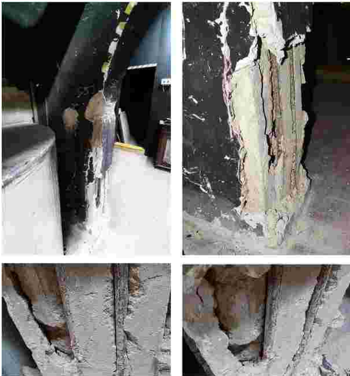
Obr.22-25 : Po odstranění omítky se ukázal celý rozsah poškození sloupu v sondě S5J, kde hlavní výztuž v čele sloupu je i z částí betonu vytržena (vyboulena) směrem do prostoru divadla. Za zmínku stojí i nulové krytí výztuže, které souvisí s absencí třmínků. Je zcela odtržená čelní strana sloupu s výztuží až do výšky 1200 mm nad podlahou, z této strany se odděluje se dvojice vodorovných trhlin napříč sloupem ve výšce cca 750 mm nad podlahou.
