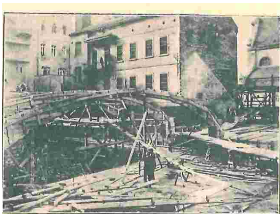
Bednění obloukové střechy nad slavnostním sálem.
