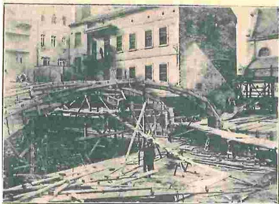
Bednění obloukové střechy nad slavnostním sálem.
