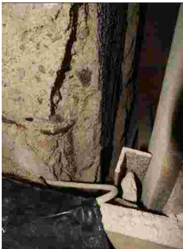
Obr. 12: Sloup Sc6M s výrazným narušením a odtržením krycí vrstvy betonu korodující výztuží v patě sloupu, po odstranění odtržené vrstvy je dobře patrná masivní koroze výztuží
