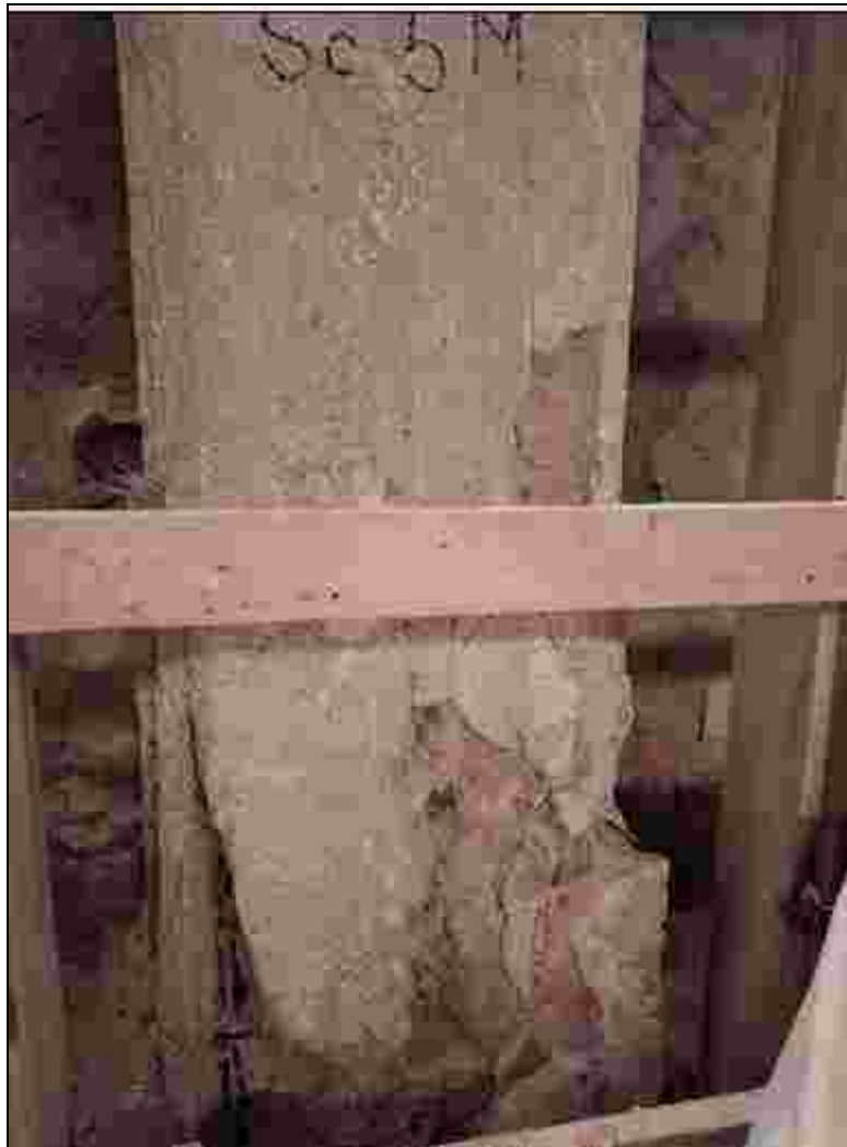
Obr. 4: Sloup Sc5M s výrazným narušením a odtržením krycí vrstvy betonu korodující výztuží
