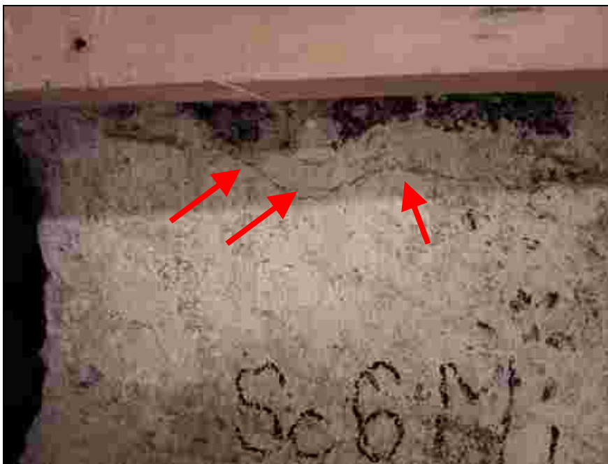
Obr. 13: Sloup Sc6M - vodorovná trhlina ve výšce přes 1m nad podlahou
