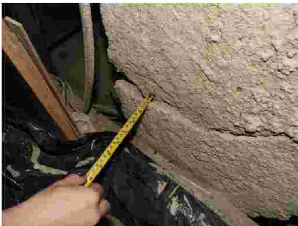
Obr. 9, 10: Sloup Sc6M s výrazným narušením a odtržením krycí vrstvy betonu korodující výztuží v patě sloupu - detaily dokumentující vyklonění odtržené vrstvy betonu
