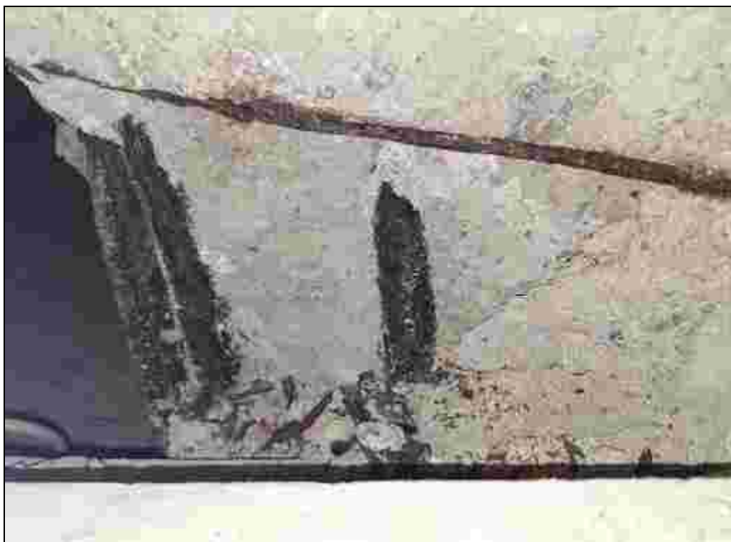
Obr. 14: Sloup SC6M s výrazným narušením a odtržením krycí vrstvy betonu korodující výztuží v patě sloupu, po odstranění odtržené vrstvy je dobře patrná masivní koroze výztuží. Na záběru dvojice výztuží ze základu končící v patě sloupu hákem, a mezi nimi jedna hlavní výztuž sloupu
