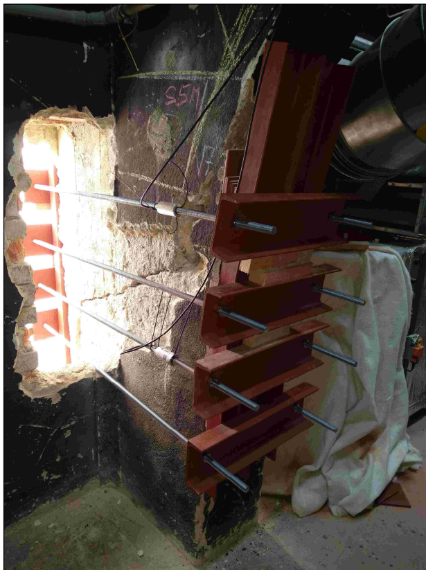
Obr.18-19 : Provizorní statické zajištění jednoho ze sloupů v rámu 5. ocelovými prvky spojenými závitovými tyčemi, s osazenými měřicí deformace.
