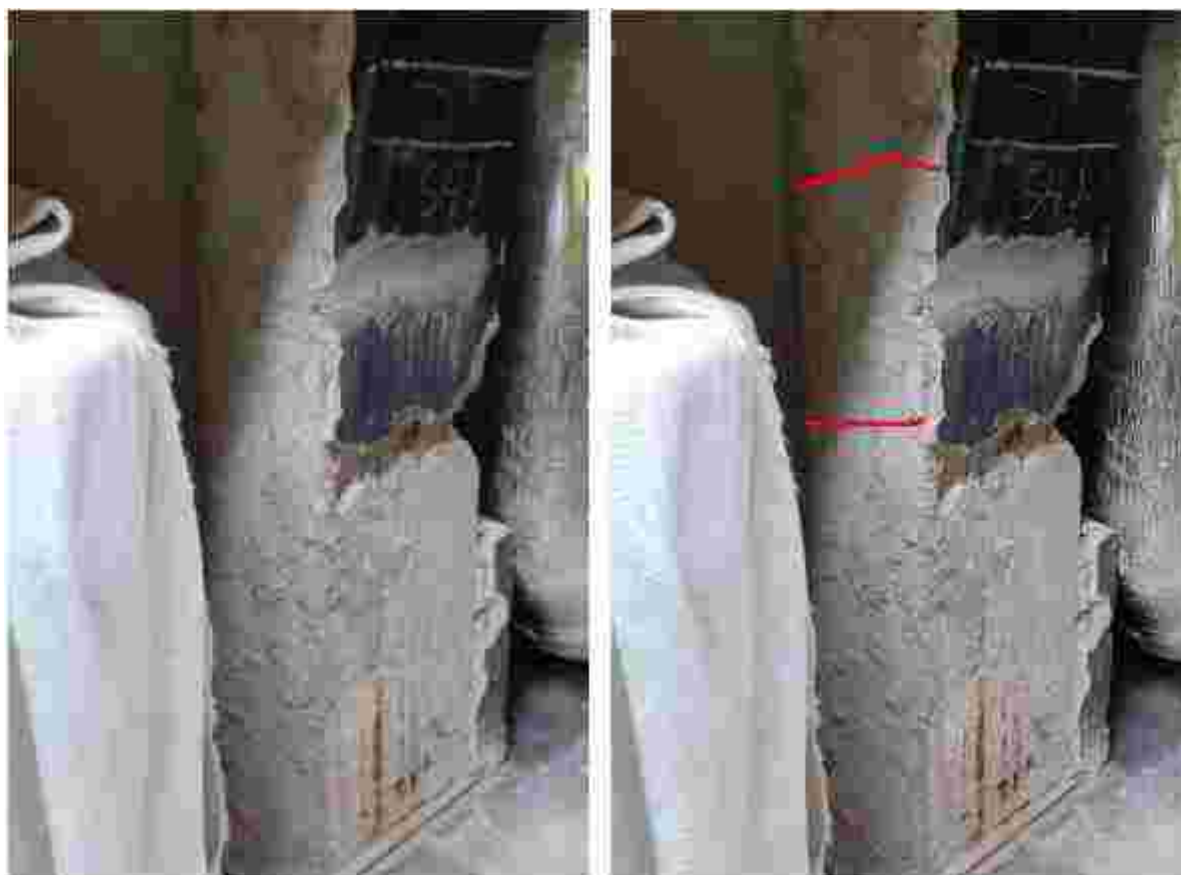
Obr.34-35 : Místo sondy S4J po odstranění části omítky, jsou patrné vodorovné trhliny ve výšce cca 900 a 1320 mm nad úrovní podlahy. Pro názornost jsou v pravém obrázku trhliny zvýrazněny červeně.
