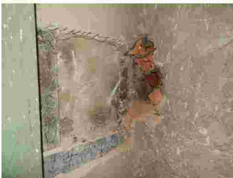
Obr. 3: Sloup Sc4M, mezi ocelovými pláty jsou slabě patrné šikmé trhliny, které byly patrně jedním z důvodů zesílení sloupu
