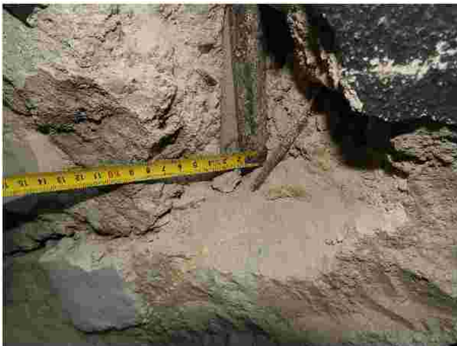
Obr.10 : Detail vytržené výztuže z původní polohy v sondě S5M, původní otisk v cementové matrici dobře patrný.
