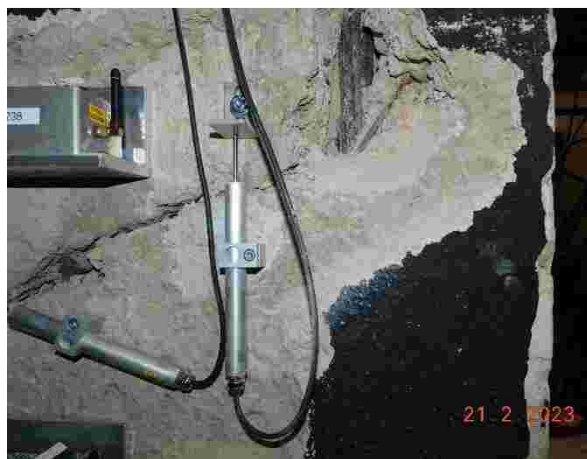
Foto z instalace 21.2.2023, detail snímače DH15
