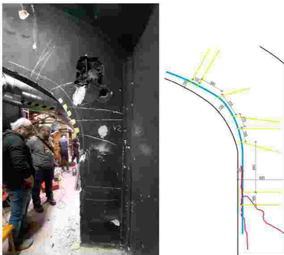
Obr.20 : Celkový pohled na místo sondy S5J spolu s vykreslením polohy trhlin a výztuže opět jasně ukazuje, že průběh trhliny souvisí se způsobem vyztužení, a velkou roli hraje poloha třmínků ve sloupu, která trhlínu zde posunula níže k úrovni podlahy osvětlovací galerie.
