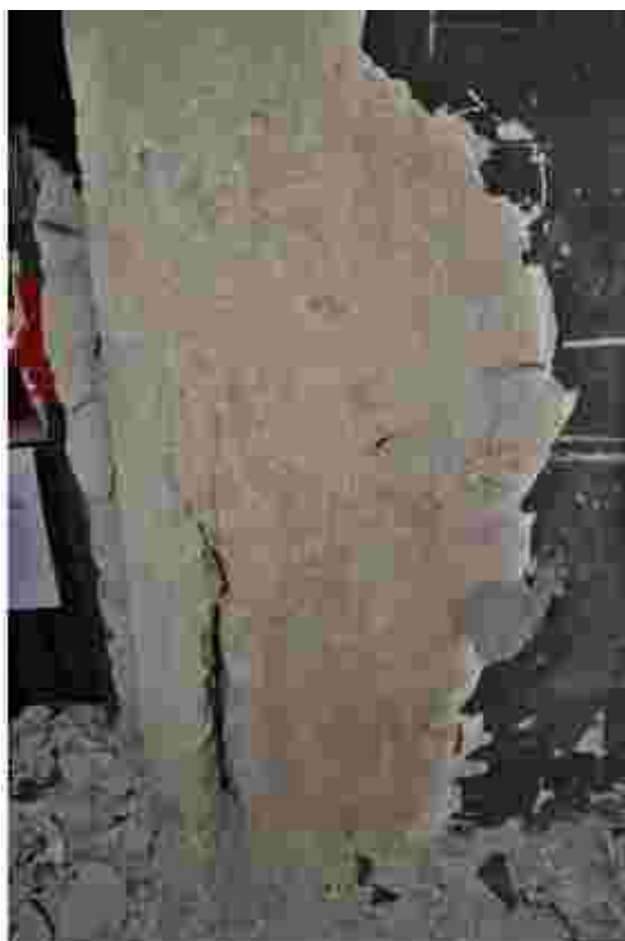
Obr.49 : Místo sondy S6M, po odstranění omítky se jasně ukázalo, že jedna z trhlín kopírovala odtržení čelní strany betonu i s výztuží (boulení, mimo jiné v důsledku absence třmínků).
