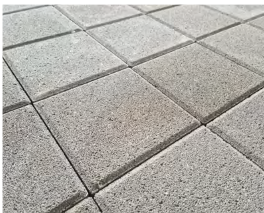
obr. 31 dlažba z vodopropustného betonu B.3.2.e šedá
