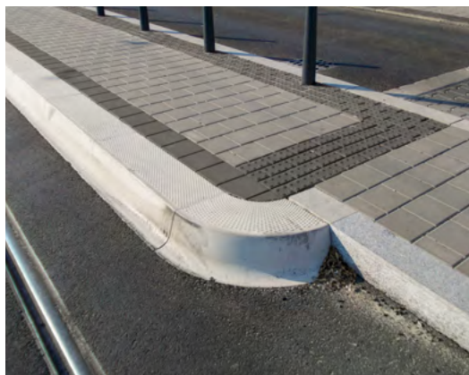
obr. 38 kasselský zastávkový obrubník B.3.5.c beton, světle šedá
