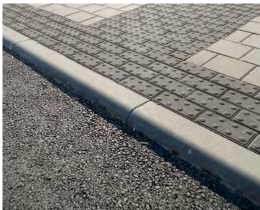
obr. 37 betonový obrubník B.3.5.b
