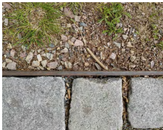
obr. 39 ocelová obruba jako rozhraní mezi dlažbou a zelení B.3.5.d
