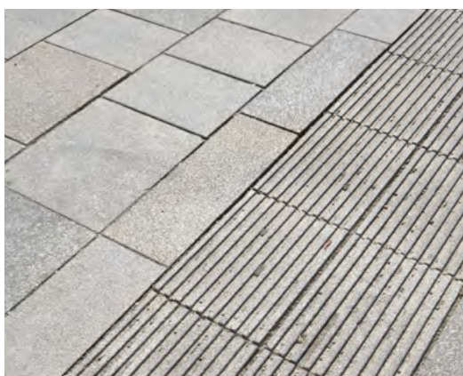
obr. 14 vodící linie, dlažba s drážkami B.2.6.b žula, světle šedá
