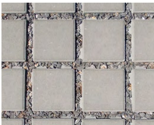
obr. 30 distanční dlažba B.3.2.d beton, světle šedá
