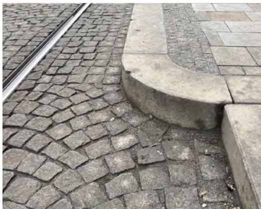
obr. 19 — ul. Joštova zastávkový obrubník atypický přímý a přechodový B.2.7.e žula, světle šedá
