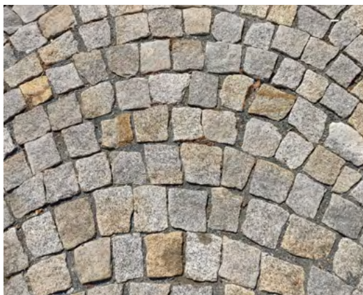
obr. 6 — ul. Starobrněnská drobná kostka štípaná B.2.3.b žula, 10 × 10 × 10 cm, mix barev
