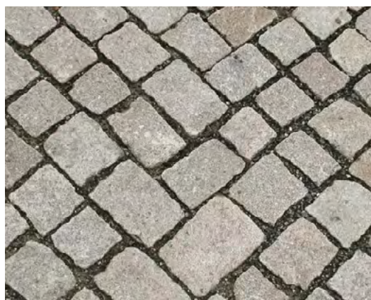
obr. 8 velká kostka štípaná B.2.3.d žula, 15 × 17 cm, šedá
