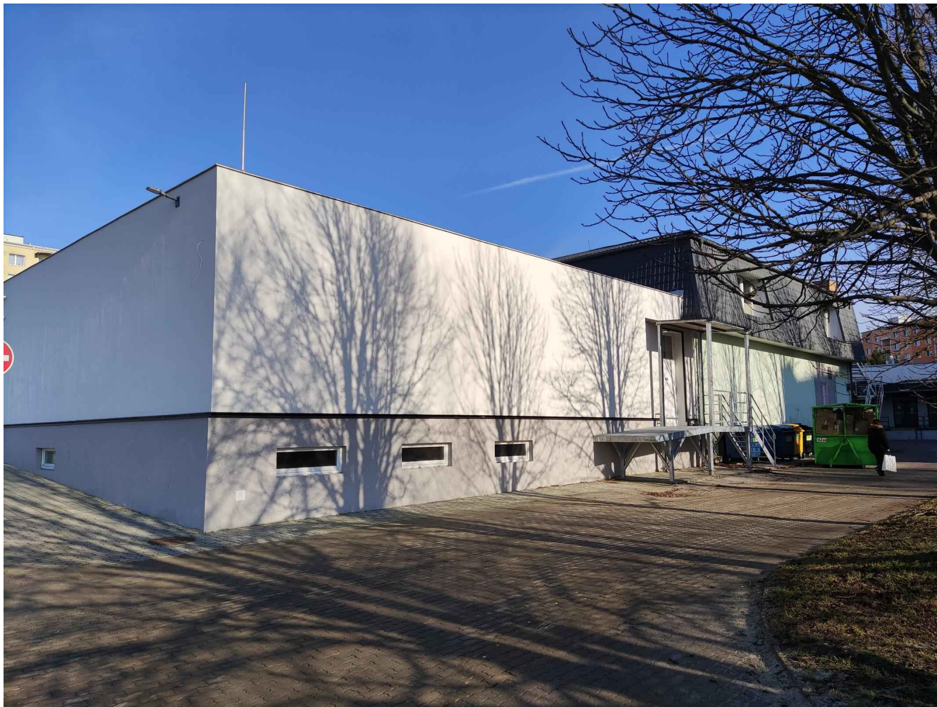
Nově postavená přístavba prodejny domácích potřeb Ečerova 1231/2b
