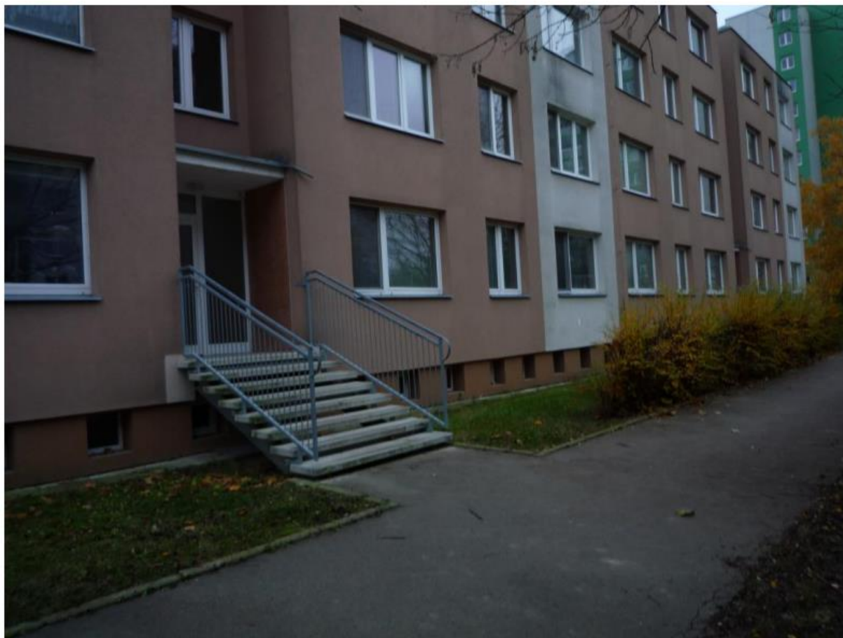
Zadní vchody domu Velkopavlovická 6, 8, Brno
