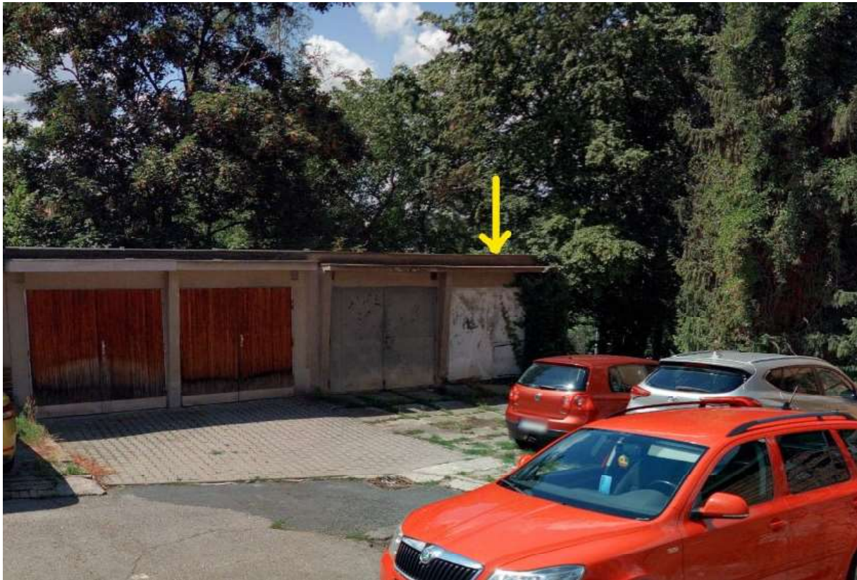
Řadová garáž situovaná na pozemku p.č. 2330/3 (vlastnictví navrhovatele) a pozemku p.č. 2330/4 (vlastnictví města Brna) vše v k.ú. Žabovřesky
